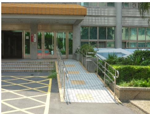
6 樓出入口坡道、扶手
