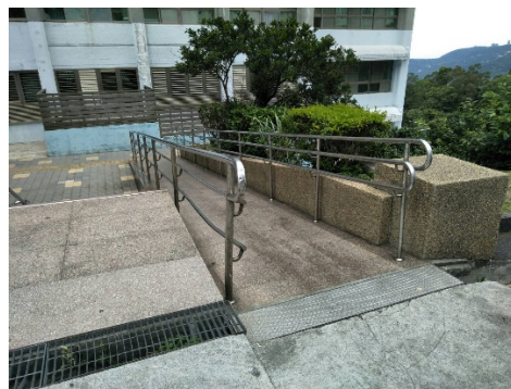
5 樓戶外坡道進入大忠館餐廳
