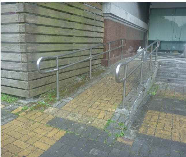
東側(臨大成館)坡道及扶手
