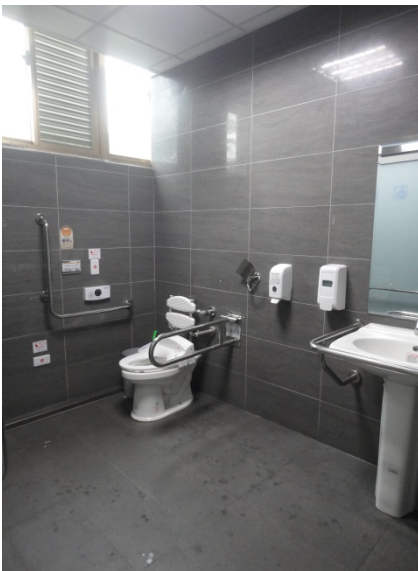
1 樓(臨華岡路)1 間無障礙廁所 (通用設計，內部設置免治馬桶、洗臉盆，扶手、緊急救助鈴)
