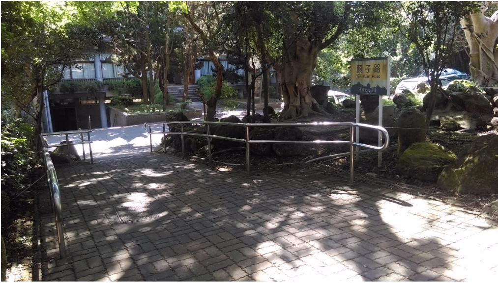
無障礙坡道扶手(百花池、大仁館間)
